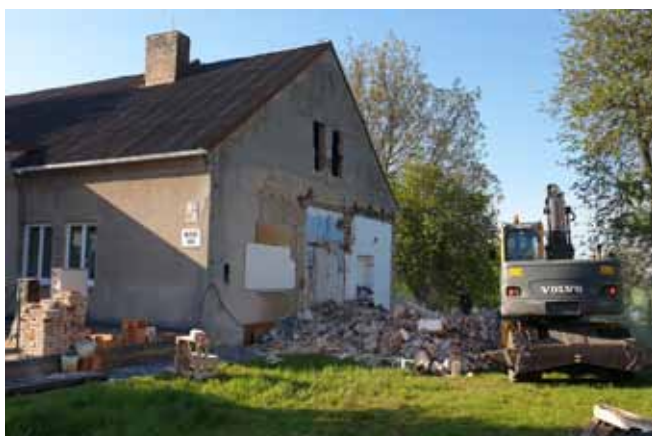
MŠ Zahájení prací
