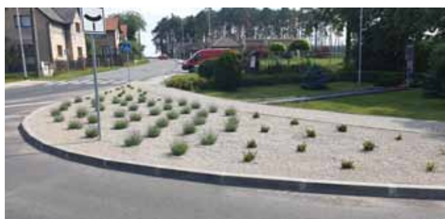
UKONČENÍ PRACÍ - vegetační úpravy křižovatky
