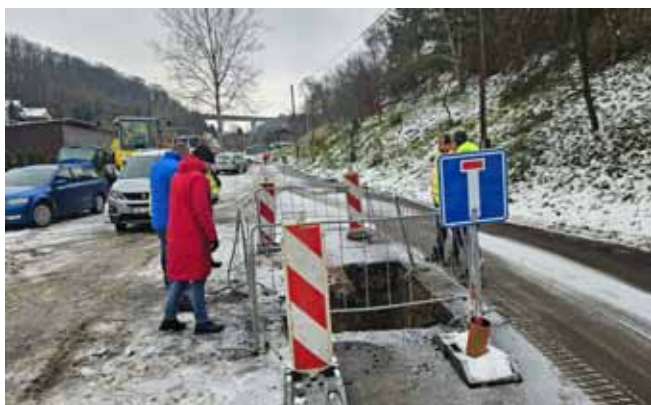
Výstavba kanalizace - napojovací místo v Hrdlořezích
