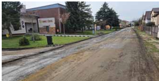
Obnova komunikací - ulice u OÚ před pokládkou 1. asfaltové vrstvy
