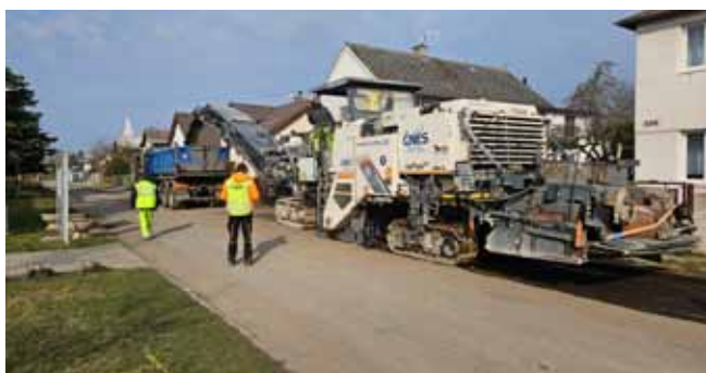
Obnova místních komunikací - zahájení prací v ulici u Obecního úřadu a KD
