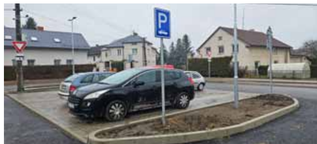
Výstavba chodníku 3. etapa - dokončení Dopravního značení
