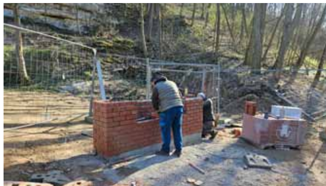
ČSOV - Výzdívka pilíře elektro
