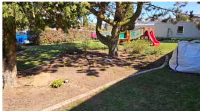
Vegetační úpravy v MŠ - práce před dokončením
