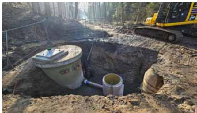
ČSOV 1 - Propojování budoucí Hlavní čerpací stanice na trase Čistá - Hrdlořezy
