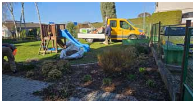
Vegetační úpravy v MŠ - průběh prací
