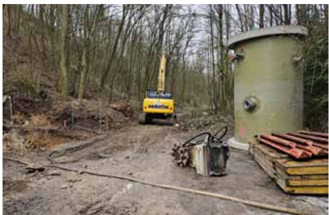
Čerpací stanice odpadních vod (ČSOVV) 1 - před zahájením prací
