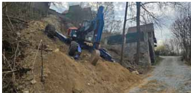
Výstavba kanalizace - KNL přípojka k čp. 9 (Údolí - Stránka)
