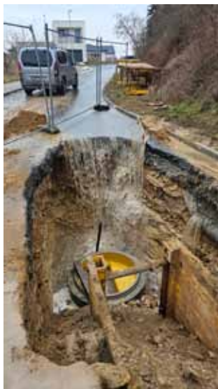
Výstavba kanalizace - úsek k nové zástavbě, rozměry počásí
