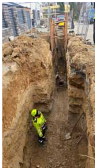
Výstavba kanalizace - Výkopové práce v Nové zástavbě, to je ale hloubka....
