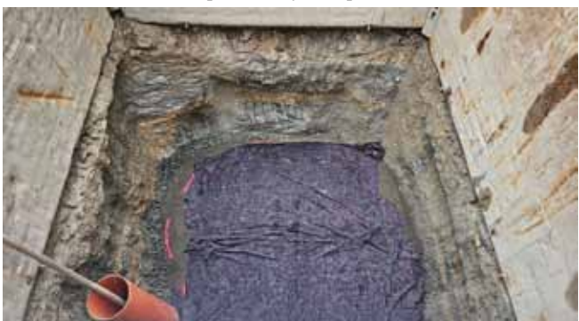
ČSOV 1 - výkopové práce ve skalním masivu
