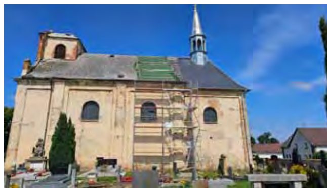
Kostel sv. Vavřince, oprava střechy 2.etapa - zahájení prací
