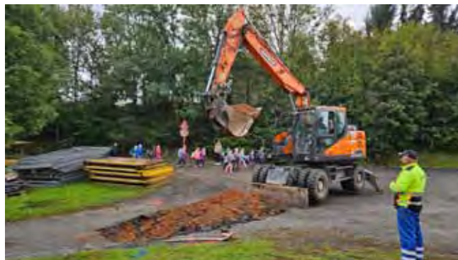
Čistá, výstavba kanalizace - 1.10.2024, zahájení prací pod dohledem žáků ze ZŠ Čistá
