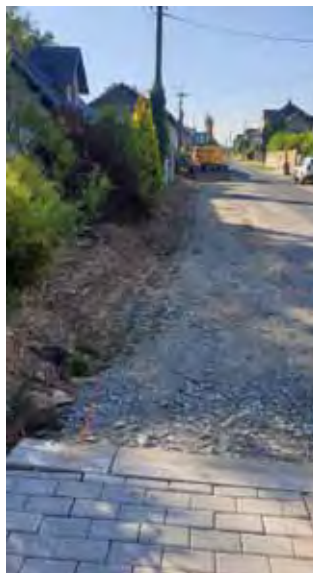
Chodník podél místní komunikace - Zahájení prací na poslední části chodníku
