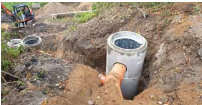
Dešťová kanalizace Stránka - Realizace spádových šachet
