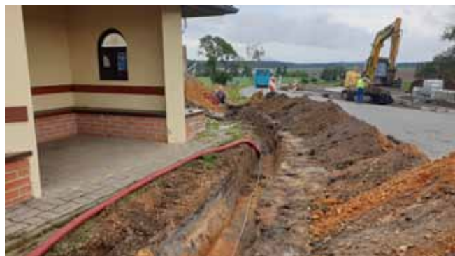
Autobusový záliv Stránka - Průběh prací na rozvodech pro V.O.
