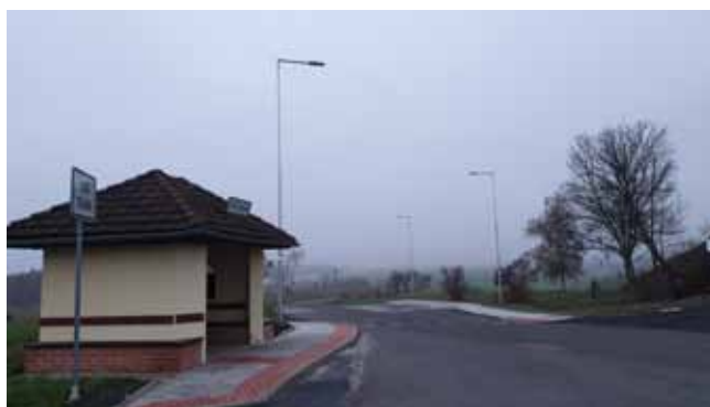
Autobusový záliv Stránka - Dokončení stavby včetně nového Veřejného osvětlení
