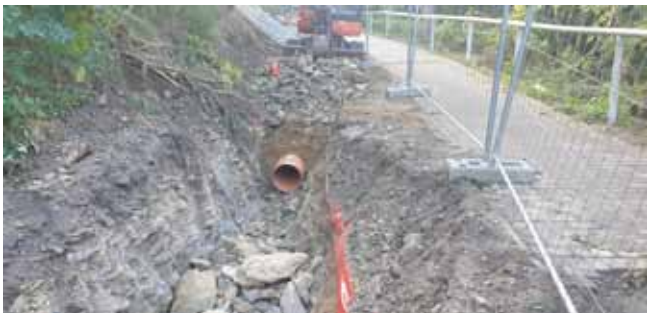
Dešťová kanalizace Stránka - Průběh prací
