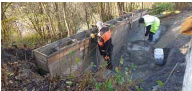
Dešťová kanalizace Stránka - Realizace opěrné zdi
