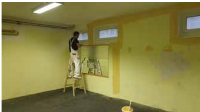
Posilovna pod OÚ - zahájení prací
