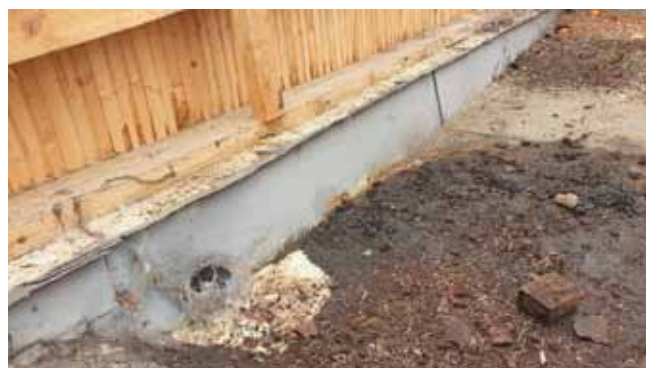
Oprava střechy vstupu do KD - stav střechy po demontáži
