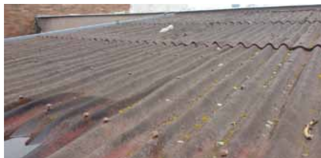
Oprava střechy vstupu do KD - starý střešní plášť
