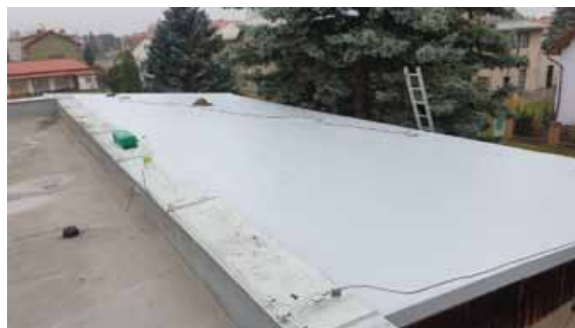
Oprava střechy vstupu do KD - Nová střecha před dokončením
