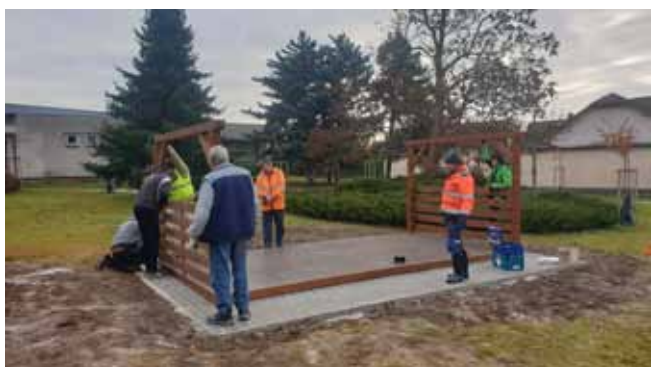
Betlém - zahájení montáže
