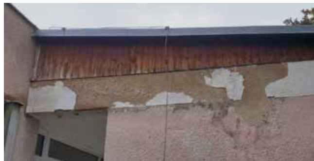
Oprava střechy vstupu do KD - Před opravou
