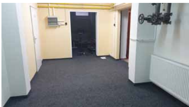
Posilovna pod OÚ - Průběh prací
