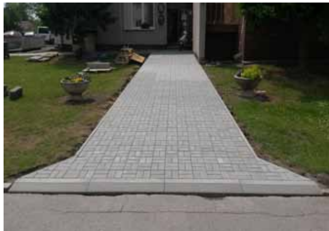
Chodník před OÚ - před dokončením
