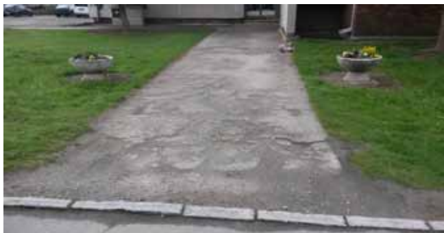
Chodník před OÚ - před opravou
