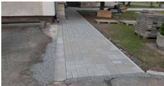
Chodník u OÚ - před dokončením
