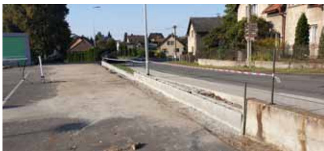
Víceúčelové hřiště - Průběh prací
