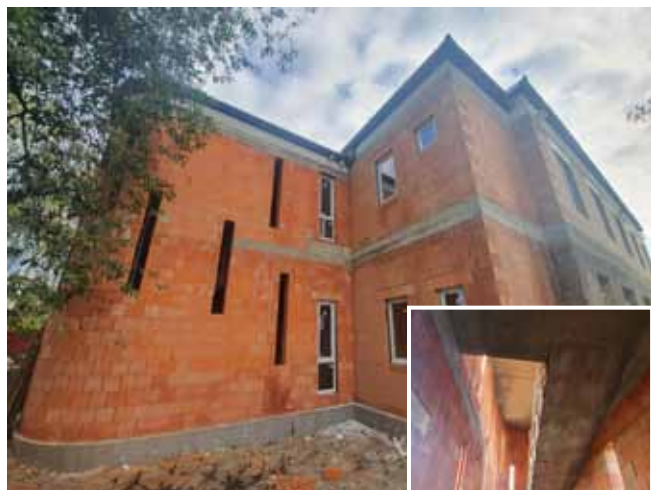
Přístavba MŠ Přístavba MŠ - Nové schodiště
