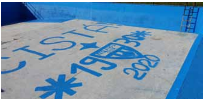
Natěr Požární nádrže
