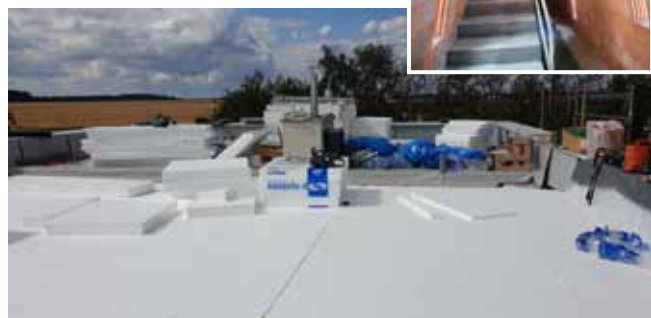
Přístavba MŠ - Nová střecha
