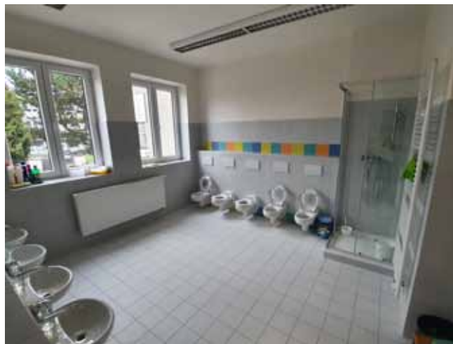
Přízemí MŠ - WC - před dokončením
