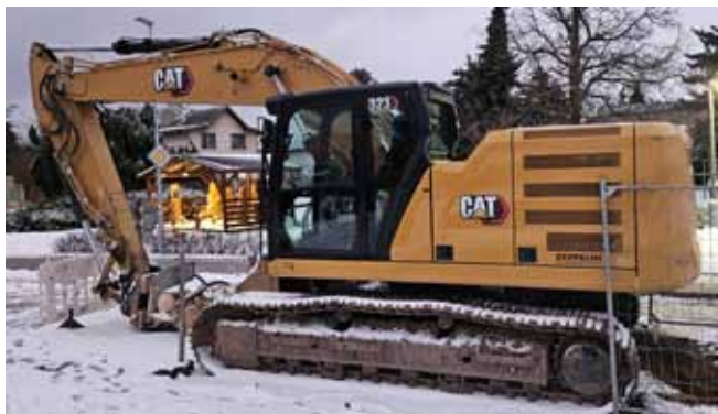
Zahájení prací v roce 2025 - Centrální část obce
