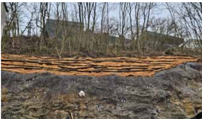
Stabilizace skalního svahu - Dokončení prací, celkový pohled
