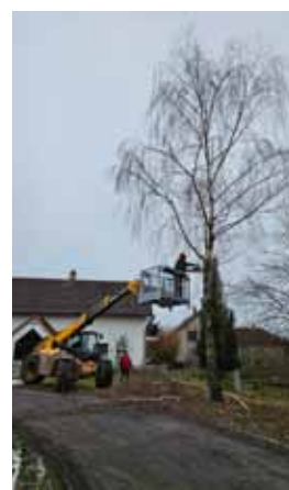
Ošetření a kácení stromů z důvodu Výstavby kanalizace
