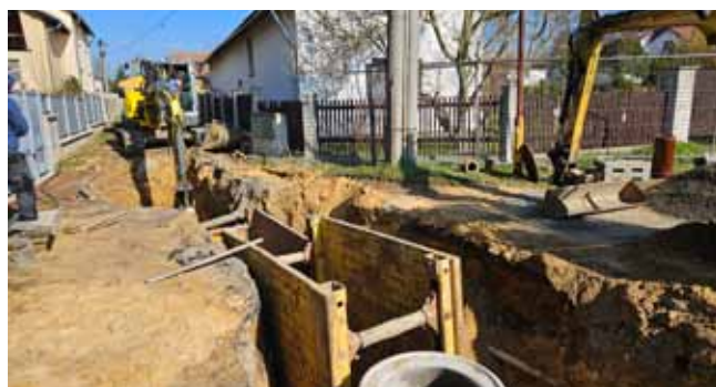
Pracovní četa VÝCHOD - Stavební práce na Stránce
