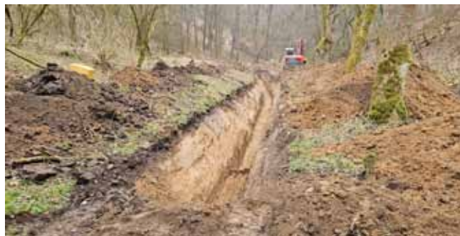
Pracovní četa SEVER 1D - Výkopové práce na Výtaku do Hrdlořez
