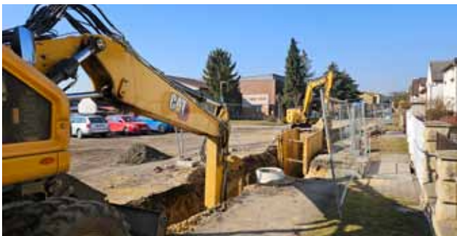
Pracovní četa ZÁPAD - Práce v ulici u Obecního úřadu
