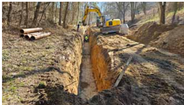
Pracovní četa SEVER 1C - zahájení prací v údolí pod hřištěm
