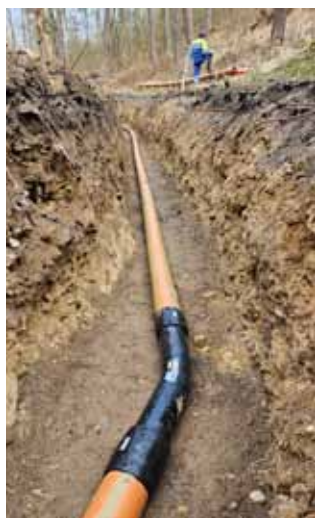
Pracovní četa SEVER 1D - pokládka a montáž výtlačného potrubí
