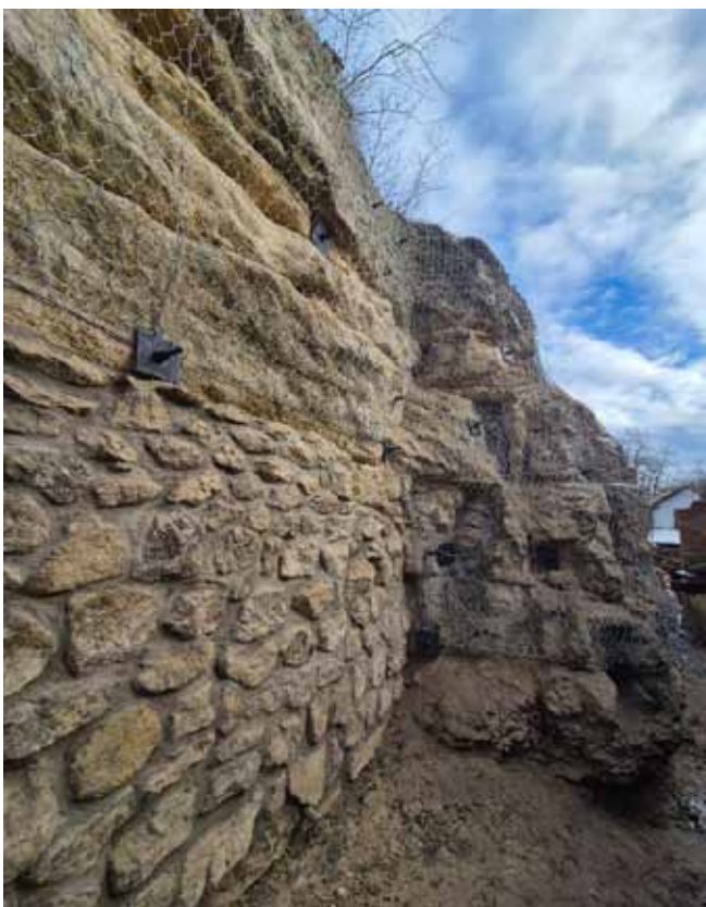
Stabiliza skalního svahu - Dokončení prací, detailní pohled
