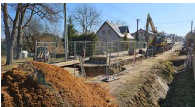
Pracovní četa SEVER 1A - zahájení prací od křižovatky U pomníku
