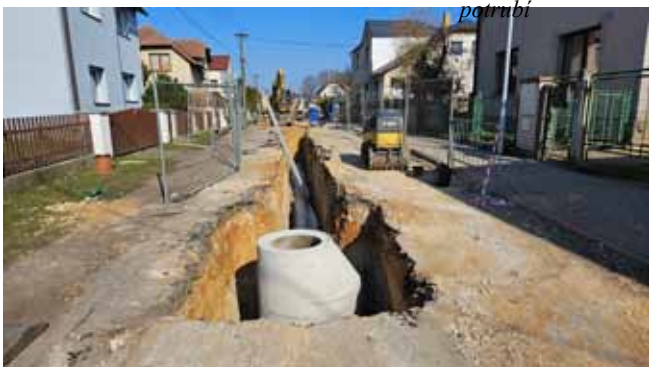
Pracovní četa SEVER 1A - Dokončení hlavní stoky úseku Pomník-Obchod
