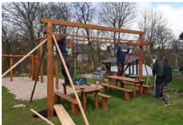
ZŠ Čistá - vybudování nového přístřešku pro žáky - zahájení prací
