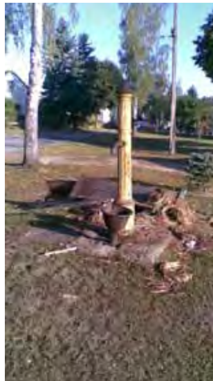
Vodní pumpa návěs Týnec - Původní stav
