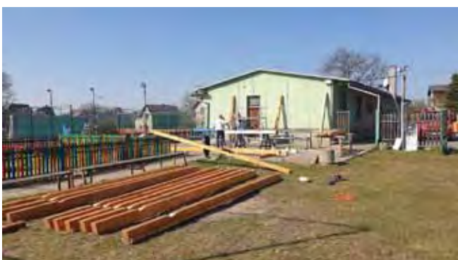
Přístřešek hřiště - Před zahájením montáže
