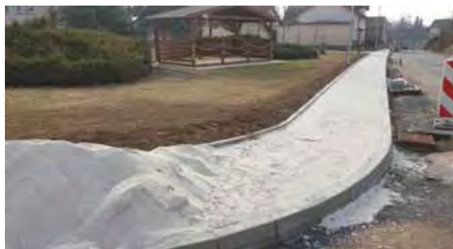
Výstavba chodníků - průběh prací, Zámková dlažba na tělese chodníku
