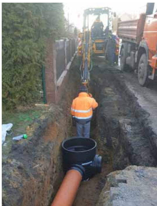
Výstavba chodníku - průběh prací dešťové kanalizace
