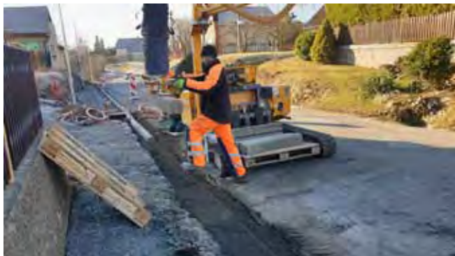
Výstavba chodníku - Pokládka obrubníků
