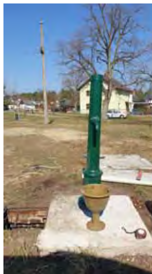
Vodní pumpa návěs Týnec - Před zahájením montáže
