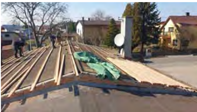
Střecha Restaurace - průběh prací na opravě
