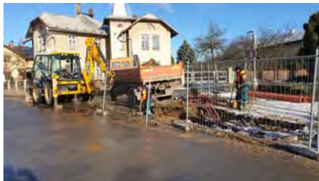
Výstavba chodníků - průběh prací.
