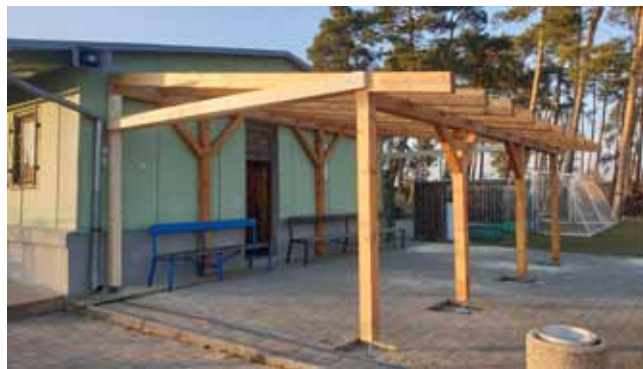
Přístřešek hřiště - Konstrukce namontována
