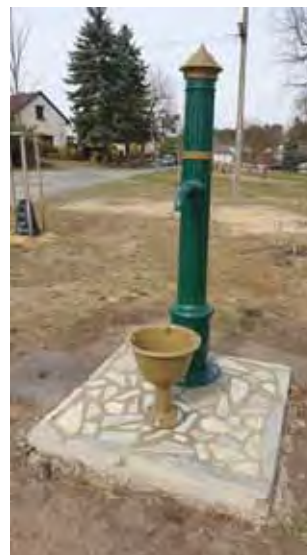
Vodní pumpa návěs Týnec - Dokončení prací
