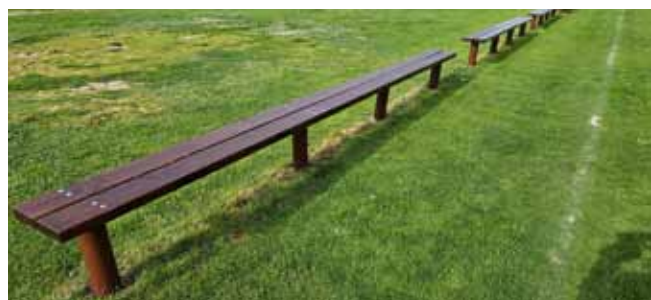
Výměna laviček na hřišti - dokončení prací, předání našim divákům
