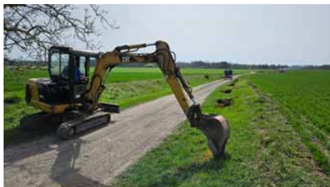
Výsadba ovocných stromů - přípravné práce
