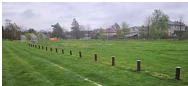
Výměna laviček na hřišti - demontáž starých laviček, nátěr
