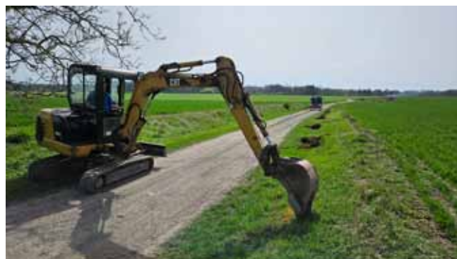
Výsadba ovocných stromů - přípravné práce
