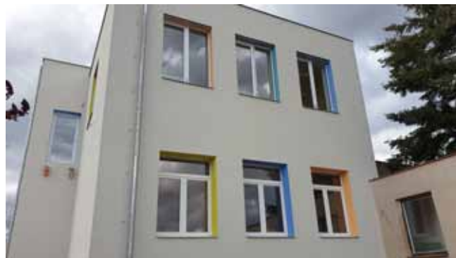
DOKONČENÍ FASÁDY - Zadní část MŠ
