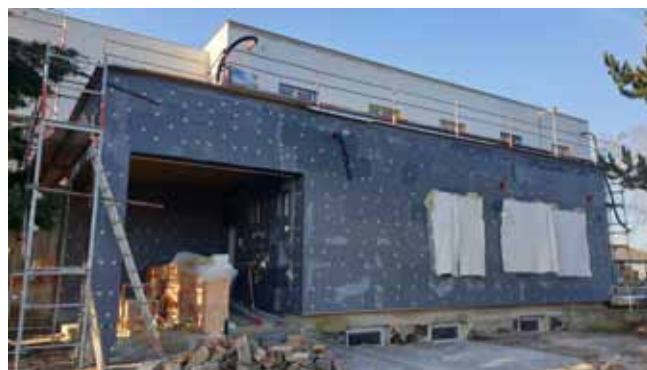
ZATEPLENÍ KUCHYNĚ A NOVÉ RAMPY
