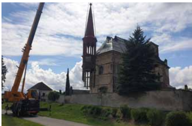
Oprava 1. etapy kostela sv. Vavřince - autojeřábnické práce
