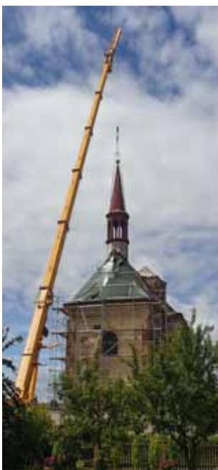
Oprava 1. etapy kostela sv. Vavřince - zahájení demontáže sanktusové věže
