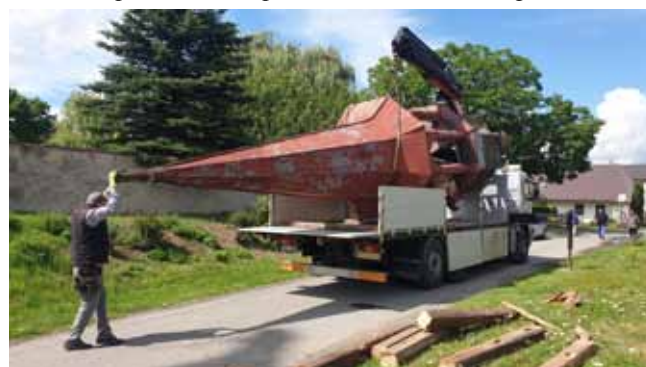
Oprava kostela sv. Vavřince - odvoz sanktusové věže, ukončení prací
