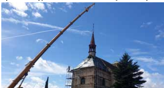
Oprava 1. etapy kostela sv. Vavřince - průběh prací na demontáži věže
