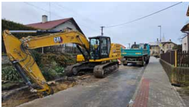
Výstavba Kanalizace - stavební práce v ulici u Domu služeb
