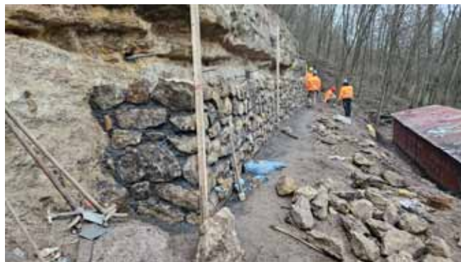
Skalní svah - dozdivání převysů v další části skalního svahu
