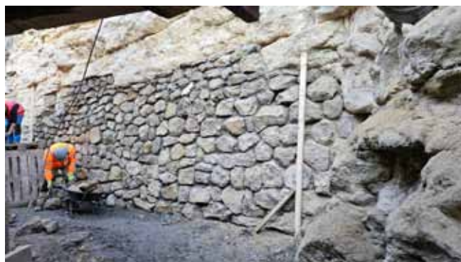
Skalní svah - vyzdivky kapes ve skalním svahu
