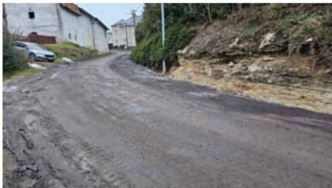
Výstavba kanalizace - zprůjezdněná komunikace na Velkou Stranu
