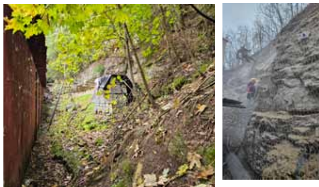
Skalní svah - situace před zahájením stabilizace svahu a zahájení stabilizace, síťování a kotvení sítí na svahu
