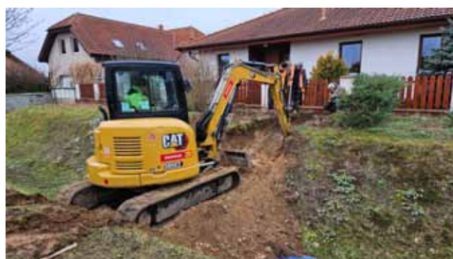
Výstavba kanalizace - stavební práce na kanalizační přípoje
