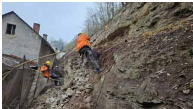
Skalní svah - odbourávání nesoudržných částí skalního svahu
