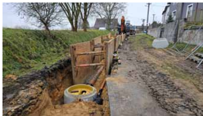
Výstavba kanalizace - stavební práce na Stránce
