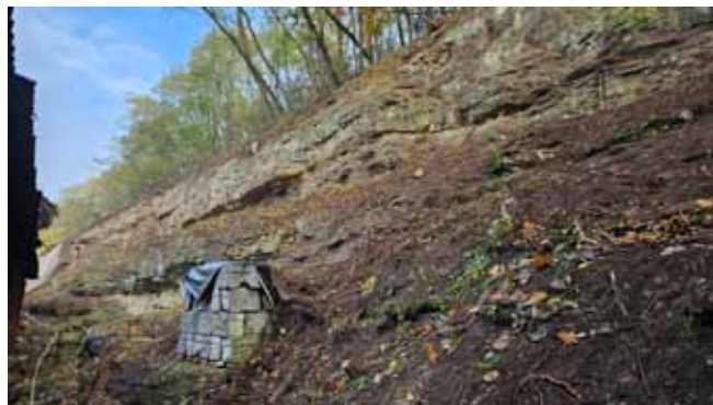
Skalní svah - průběh prací, odstranění náletových dřevin, čištění svahu
