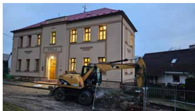
Výstavba kanalizace - stavební práce před ZŠ Čistá
