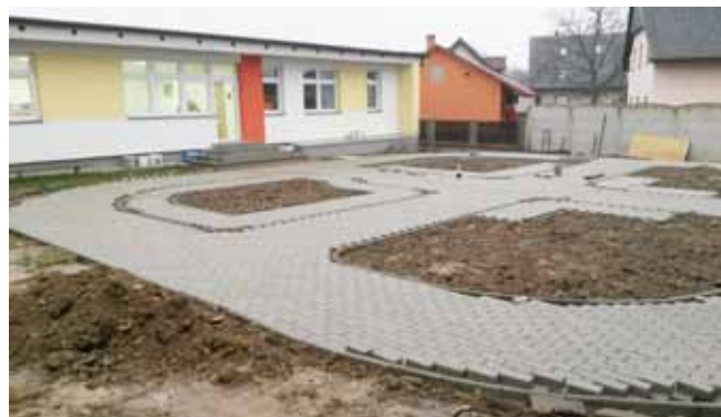
Nové dopravní hřiště za školní družinou (výstavba)
