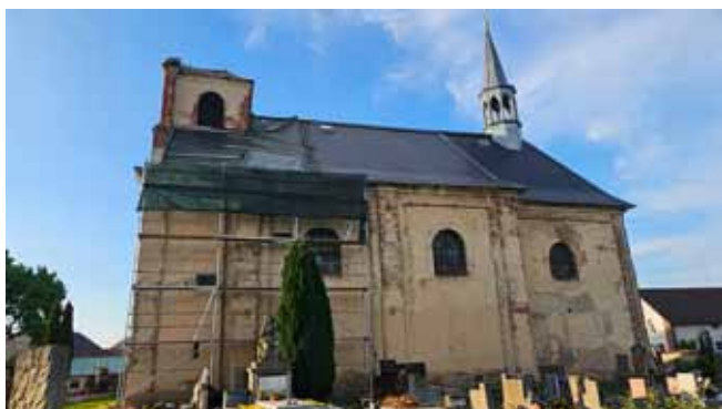
Kostel v Čisté - průběh prací na 4. etapě opravy střechy
