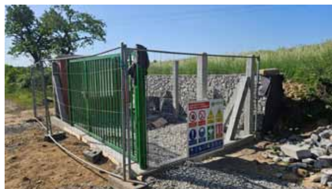
Výstavba kanalizace - ČSOV 2 na Stránce - před dokončením prací
