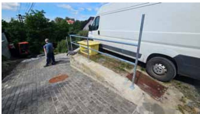
Obnova chodníku a nové zábradlí na Stránce
