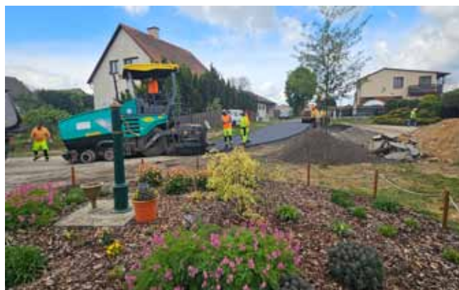
Obnova místních komunikací - náves na Týnci
