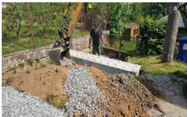
Úprava místní komunikace u č.p. 53 na Velké Straně - průběh prací
