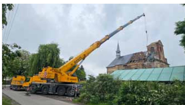
Kostel v Čisté - výškové práce na střešní konstrukci
