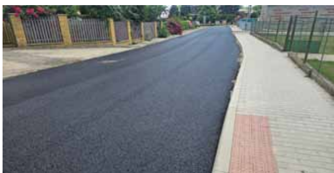
Obnova místních komunikací - ulice u MŠ, 1. asfaltová vrstva
