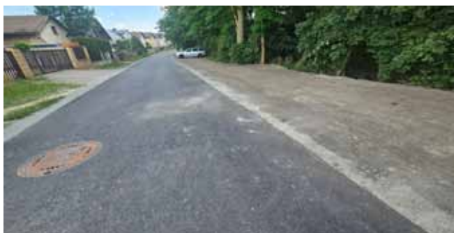
Obnova místních komunikací - ulice pod OÚ, rozšíření krajnic, nová parkovací stání
