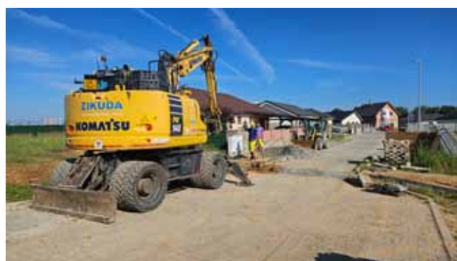
Výstavba kanalizace - 12. 06. 2026, dokončení posledního úseku páteřních stok v ZP Z16
