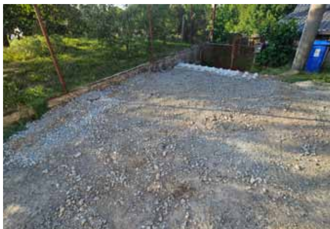
Úprava místní komunikace - před dokončením prací
