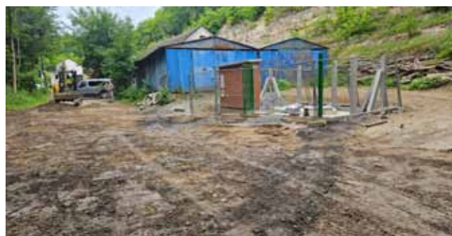
Výstavba kanalizace - ČSOV 1 v údolí - před dokončení prací
