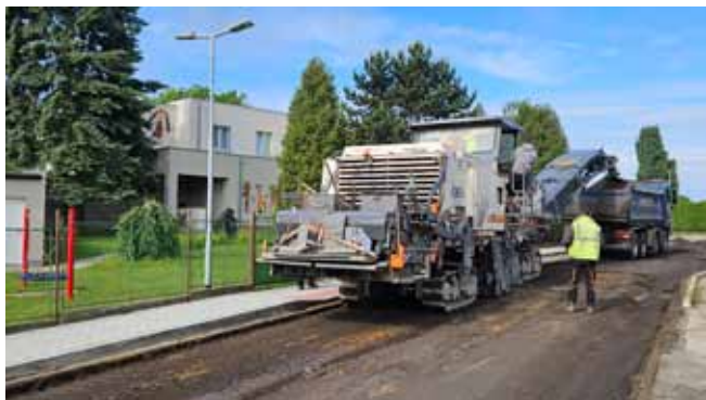
Obnova místních komunikací - ulice u MŠ Čistá
