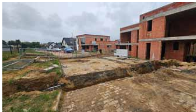
Výstavba kanalizace - kanalizační přípočky v Nové zástavbě
