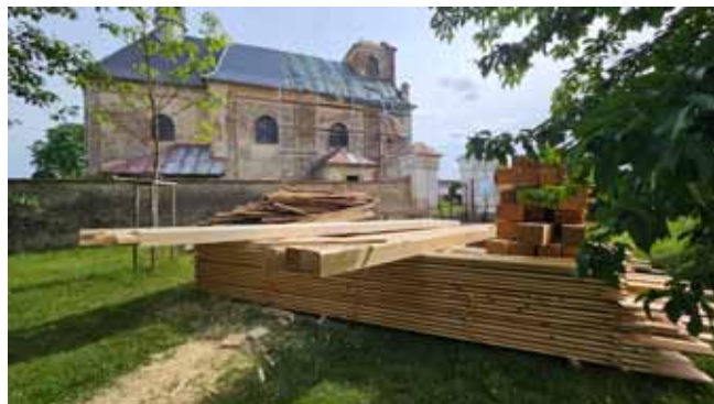
Kostel v Čisté - tesařské práce na opravě střechy
