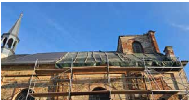
Kostel v Čisté - zahájení prací na 4. etapě opravy střechy
