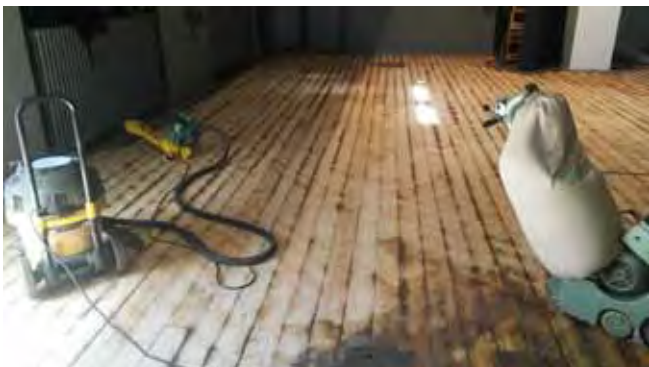
Jeviště sál KD - zahájení prací
