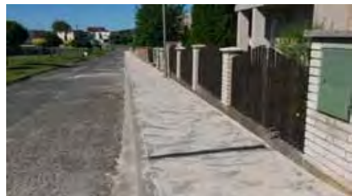
Chodník od čp 57-205 - dokončení
