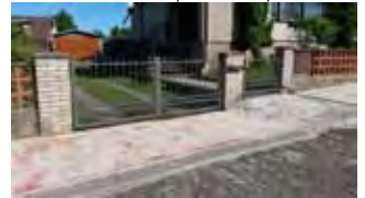
Chodník od čp 57-205 - dokončení
