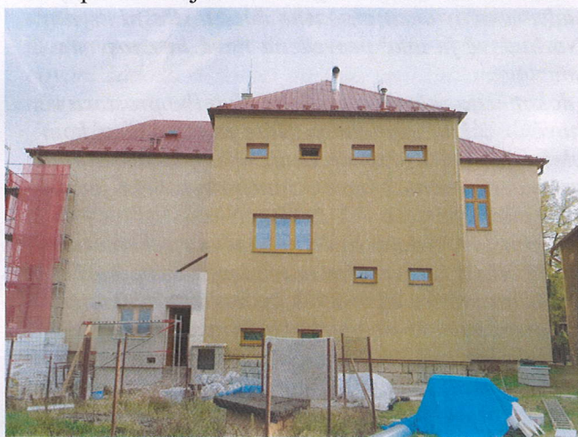
ZŠ - zadní část před dokončením
