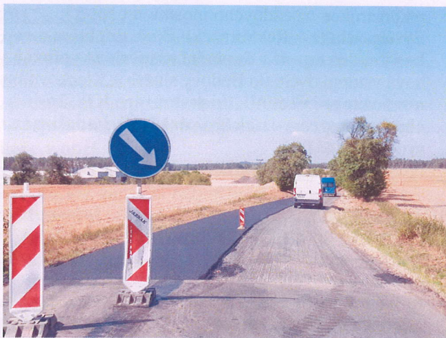
Zahájení opravy úseku Hlavní silnice III. třídy
