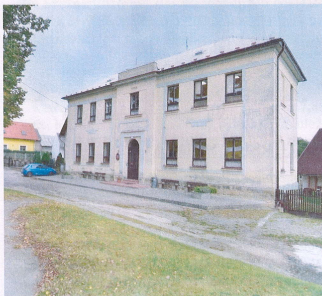
ZŠ - před zahájením Rekonstrukce
